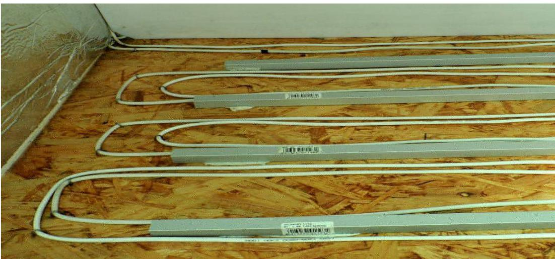
Come si vede nella foto sopra, ho steso i cavi e fissati con cambrette (chiodi ad U), ho messo dei profilati di alluminio come spessori ed ho coperto i cavi con un foglio di pvc bianco su cui si metteranno i contenitori per le piantine, uso poi delle cassette di plastica per avvicinare le piantine alle luci.
